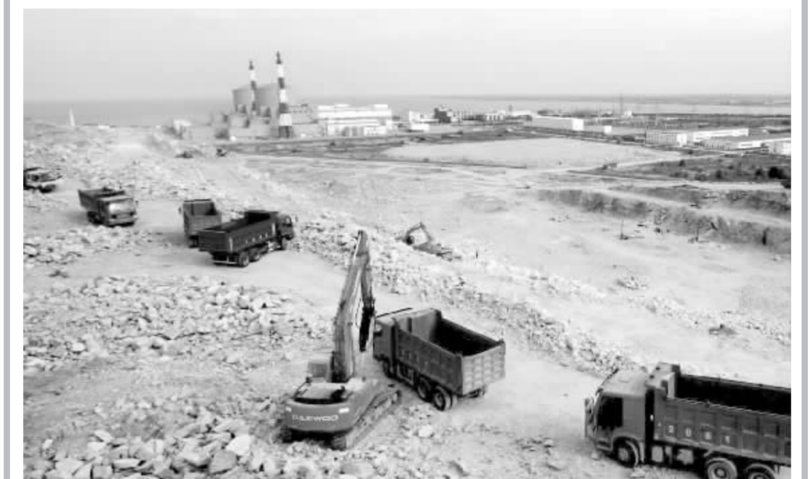
田湾核电站扩建工程加紧准备
